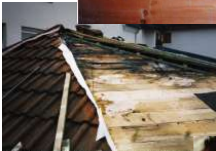
Abb. 4: Bei der Öffnung des Daches vorgefundene Fäulniserscheinungen in der Schalung des Unterdaches.
