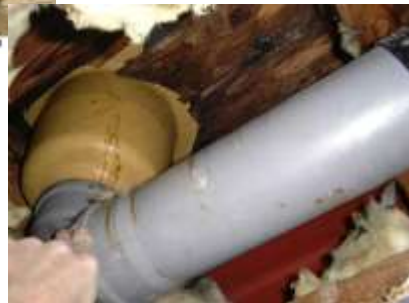
Abb. 4: Bei der Öffnung des Daches vorgefundene Fäulniserscheinungen in der Schalung des Unterdaches.
